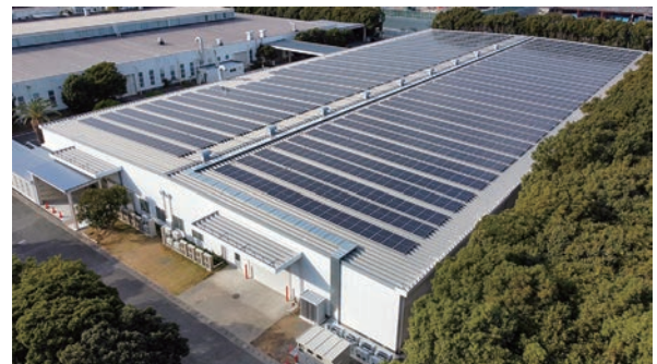
太陽光発電設備を導入した竜洋工場
