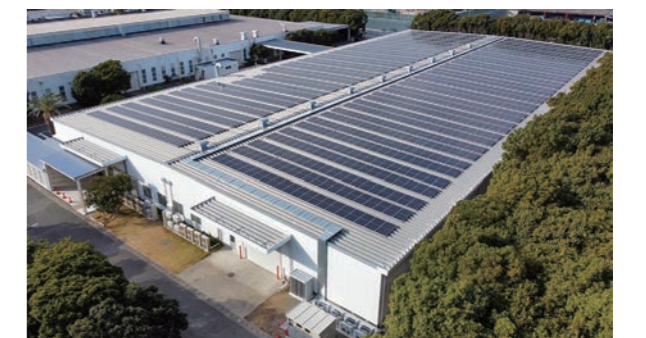
太陽光発電設備を導入した竜洋工場
