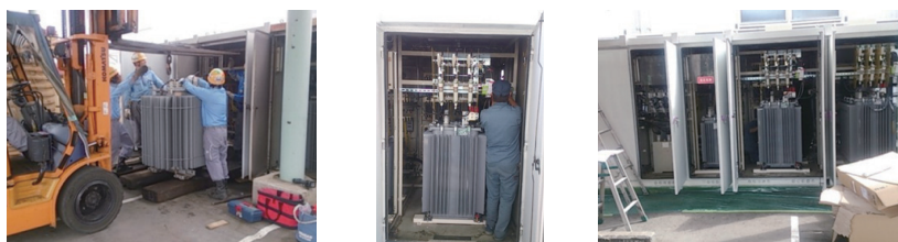
〈古い高圧変電設備の更新(松本工場)〉
