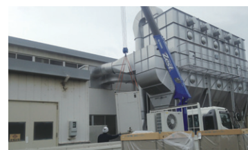
代替フロン設備への更新
