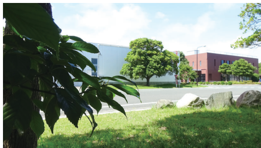
「森の中の緑の工房」竜洋工場
