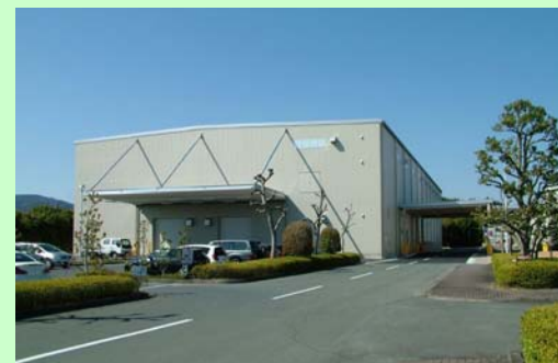
浜松工場建物工事完了(5月)
