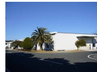
竜洋工場新倉庫
