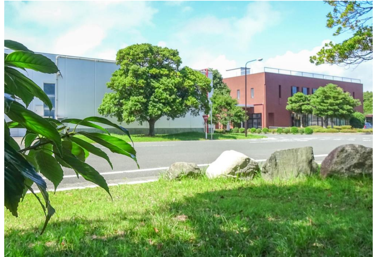
河合楽器製作所 竜洋工場(静岡県磐田市)
